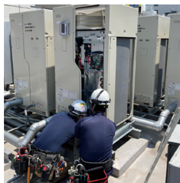
EMS制御機の取り付けの様子
